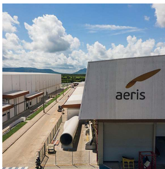
PLANTA da Aeris Energy que produz pás para aerogeradores de energia limpa
